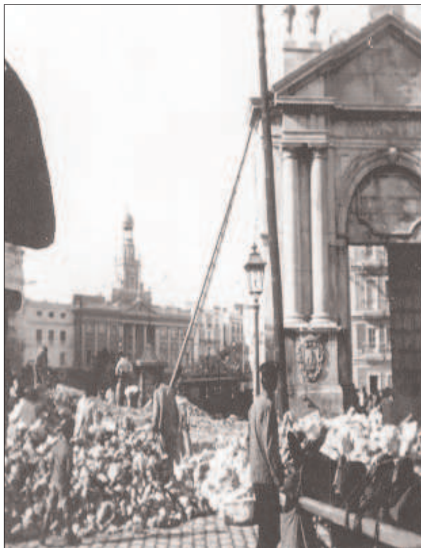
Esta fotografía muestra a los obreros derribando las murallas justo delante del Ayuntamiento, corría el año de 1904 y el alcalde Cayetano del Toro, quien había pedido al entonces primer ministro, y también gaditano; Moret el derribo de estas para liberar de espacio la ciudad y así también era un motivo para dar trabajo a centenares de obreros.
