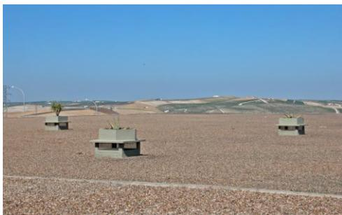
La bodega destinada al envejecimiento del brandy es una construcción aérea de planta rectangular en la que Miguel Fisac utilizó sus famosas vigas huecas o "huesos" de hormigón postesado en la cubierta que permiten la circulación del aire, como las tejas árabes en las "bodegas catedral".
