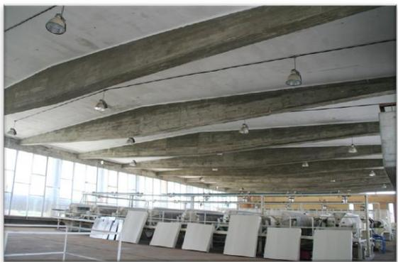
El pabellón de recepción y molturado de la uva es un funcional edificio rectangular de hormigón y cristal situado a mayor altura para que el mosto por gravedad llegue a la bodega de crianza. Lo más destacado es el alero volado de hormigón en bruto de la fachada que juega con el blanco y el cristal del cerramiento.
