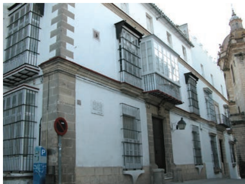
Calle Visitación, 9 y 11
