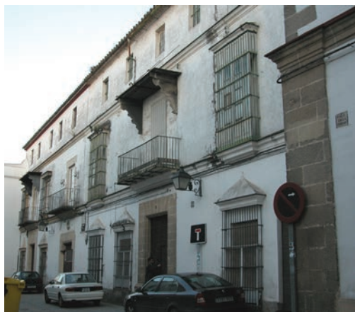
Calle Visitación, 7 y 5
