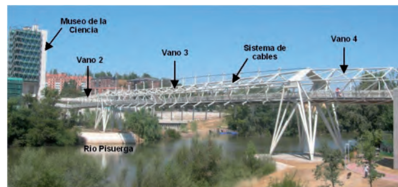
Fig. 3: Vista general de la PMC de Valladolid
