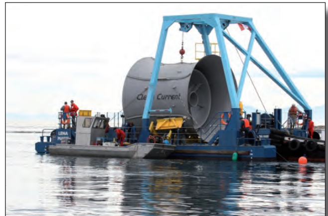
Proceso del traslado para montaje de la turbina piloto
