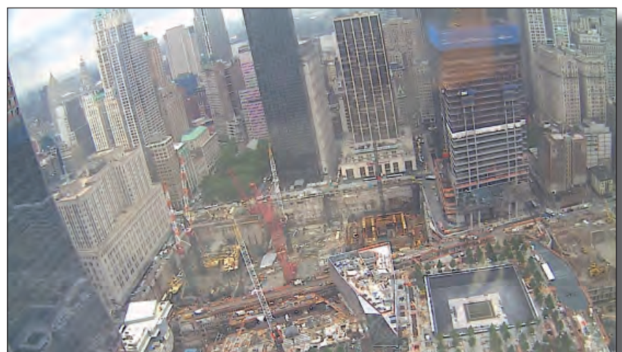
Estado de las obras en la Zona Cero a 17 de junio de 2011
