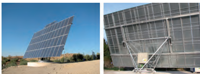
Fig. 2 a) Imagen de la parte frontal de un seguidor de dos ejes. b) Imagen de la parte trasera.
