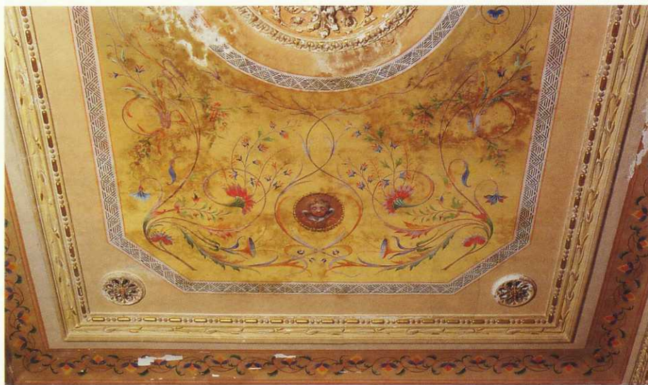
Detalle del techo de la escalera de subida.
