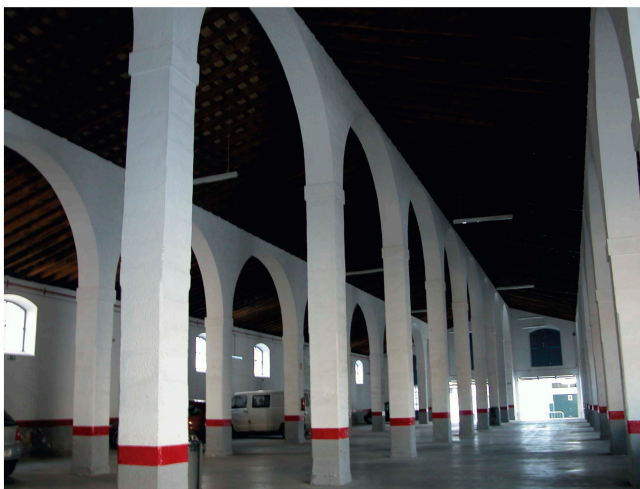
Bodega de la calle matadero. Garaje
