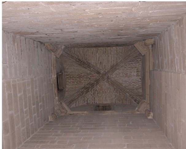
Iglesia de San Dionisio. Capilla de la torre
