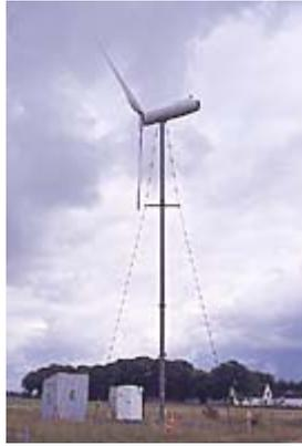
Figura 13.4.- Aerogenerador con mástil tensado con vientos
