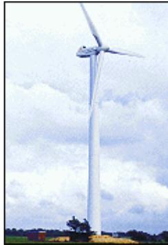
Figura 13.2.- Aerogenerador con torre tubular
