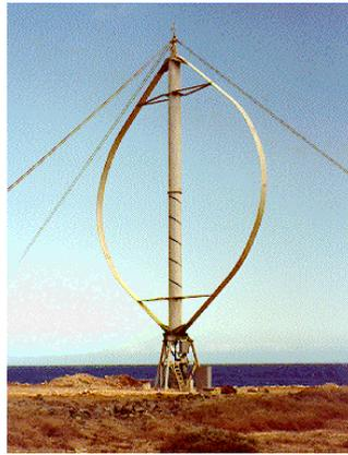
Figura 5.- Aerogenerador Darrieus
