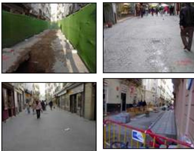
Fotos rehabilitación de la calle Pelota Fuente: Aguas de Cádiz S.A.
