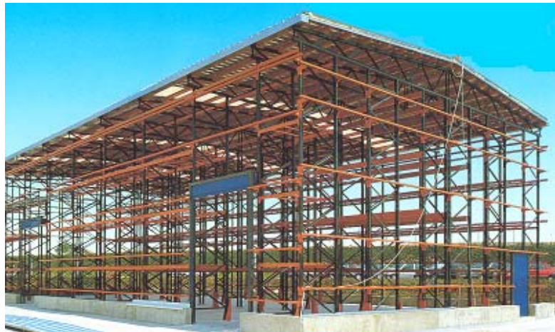
Figura 4.22. Sin cerramiento de la estructura.
