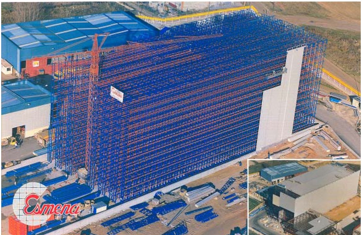
Figura 6.5. Almacén Rack Autoportante para Leche Pascual, S.A.
