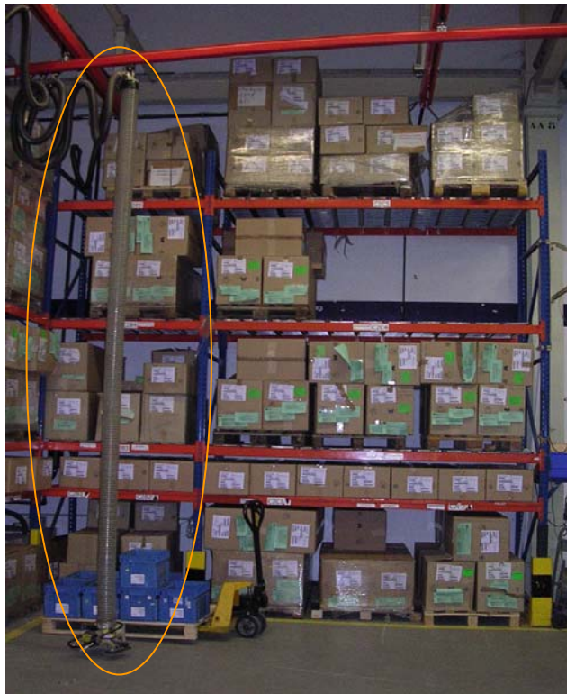
Figura 6.24. Imagen del Sistema de vacío en el almacén actual.
