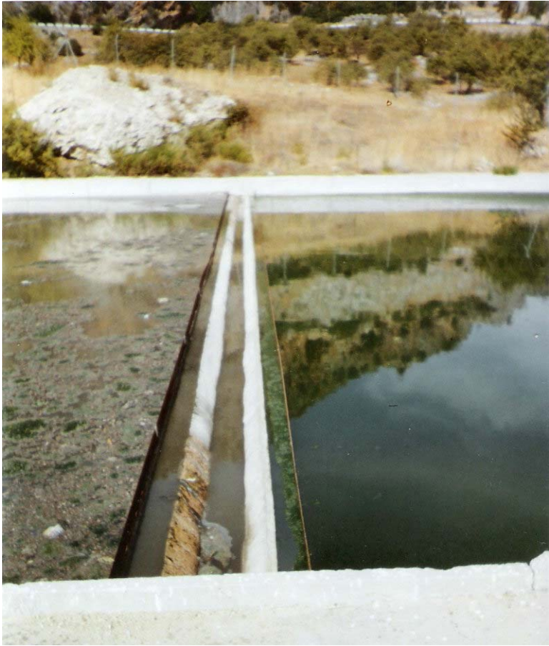
Foto 7. Detalle de la canaleta central de recogida de agua en las lagunas.
