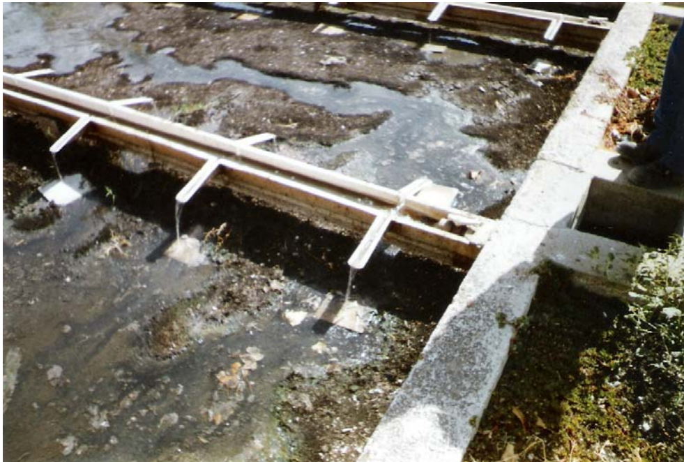
Foto 9. Detalle del sistema de reparto de los lechos.
