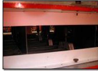
DETALLE GRADA FASE I CON DIFÍCIL ACCESO Y ESCASA VISIBILIDAD
