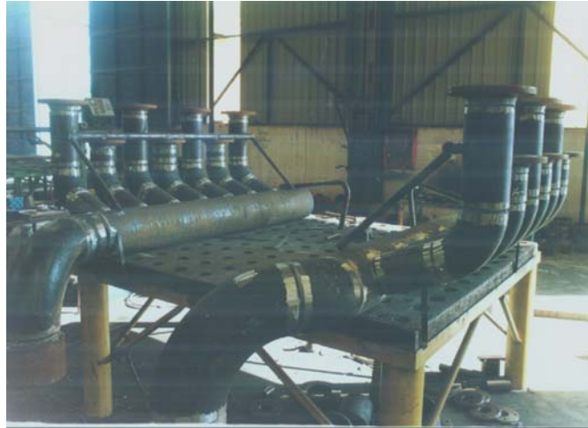
Fig.5 Montaje de Tuberías Isométricas. (Astilleros H.J Barreras de Vigo)
