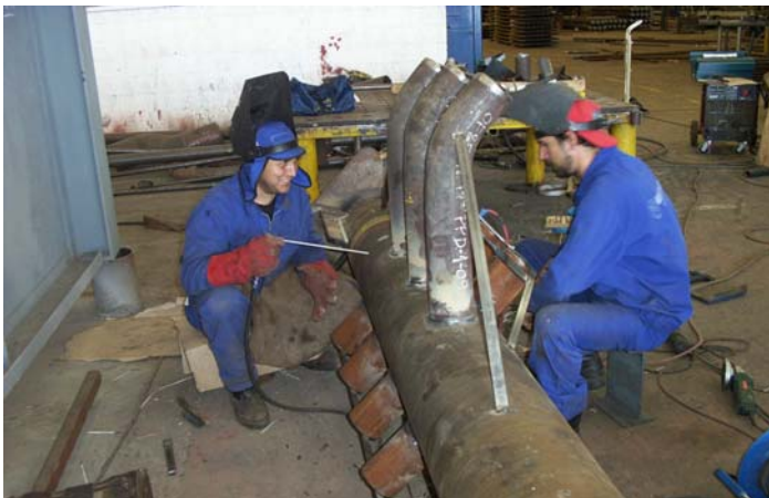
Fig. 6b) Soldadura de Colector
