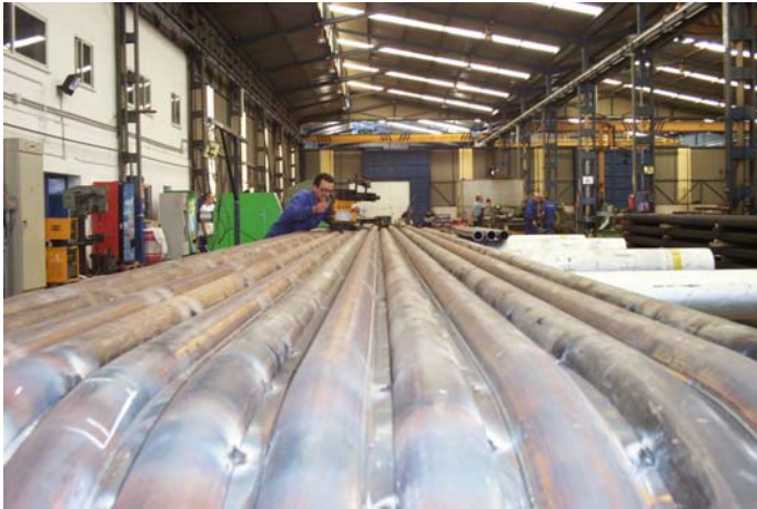
Fig. 6a) Soldadura de Paneles Membranados, unidad de sobrecalentador primario
