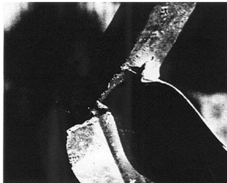
Fig. 10. Unión de perfiles huecos rectangulares que ha reventado en el baño de galvanización, por no haber practicado en la misma orificios de ventilación
