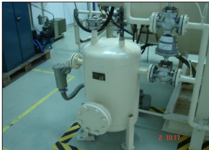
DEPÓSITO DE VACÍO DE AUTOCLAVE
