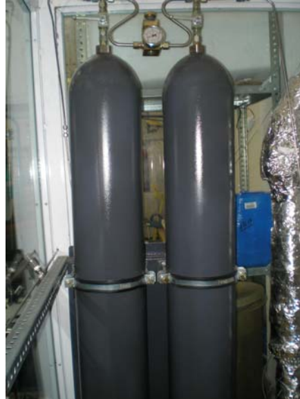
Figura 13: Fotografía de las botellas de almacenamiento de aire a presión
