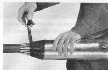
6 Encintar los dedos del cuerpo metálico con cinta aislante y, en sentido descendente, hacia la cubierta del cable.
