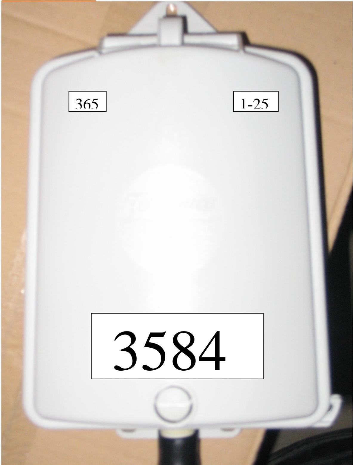
La rotulación de las cajas terminales se llevará a efecto por los “Empalmadores” encargados de conectarlas al cable, tal como se describe en la imagen, empleando números adhesivos de 10 mm. de alto para indicar el grupo ( parte superior izquierda ) y los pares
