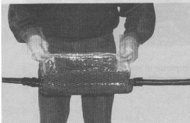
**12** Enrollar la lámina de plástico sobre si misma y colocarla sobre la parte superior del empalme encapsulante. Sujetar los extremos con cinta eléctrica y si es necesario dejar 10 mm de cinta selladora libre.
