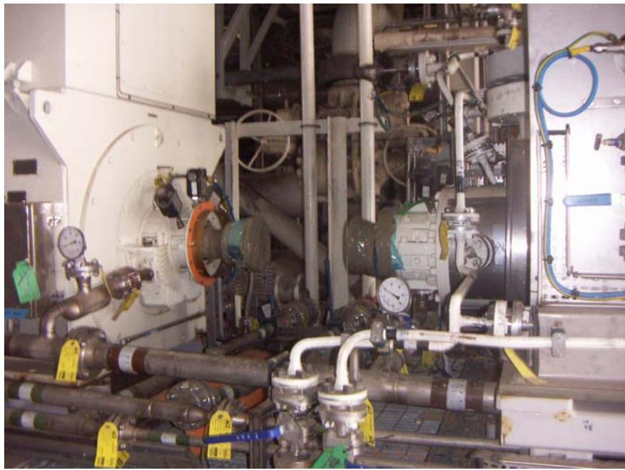
**Figura 28. foto de la bomba P-1701A a falta del montaje del eje**
