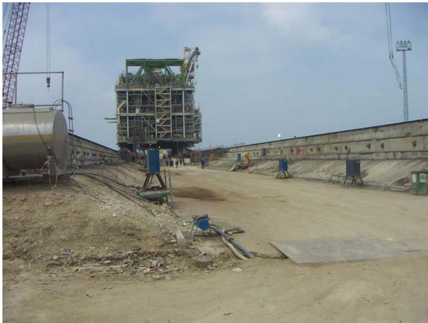
**Figura 12. foto del montaje mecánico para el traslado de la plataforma a la pontona.**
