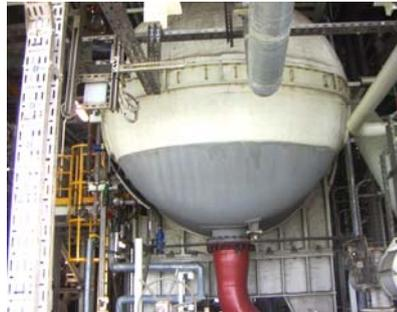
Figura 22. Descarga del tanque (V-1401) hacia la Oil Booster Pump
