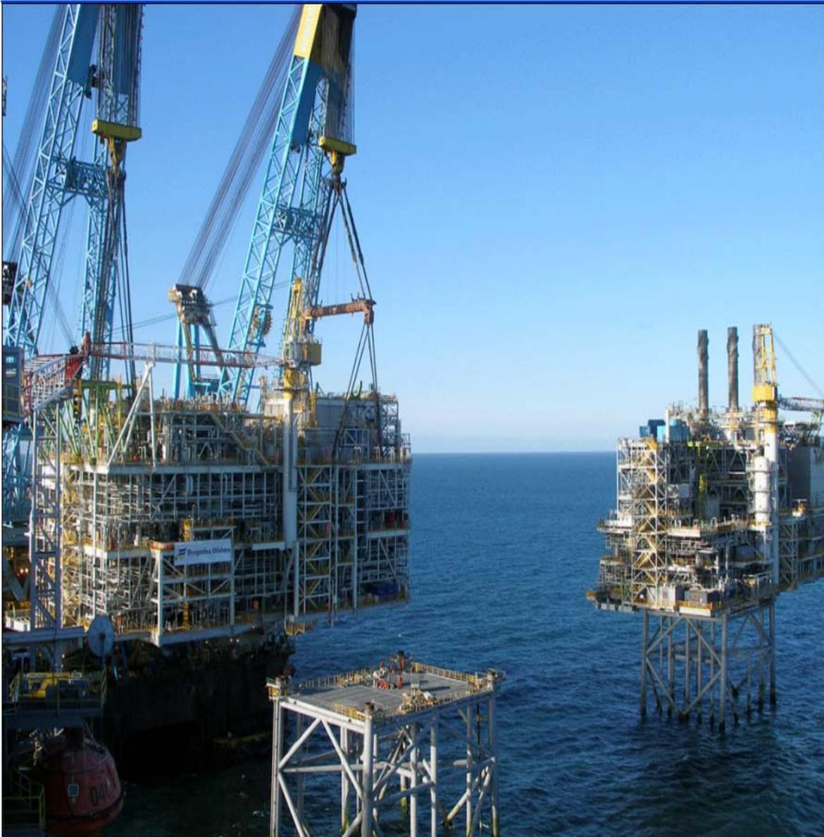
**Figura 11. foto de la instalación de la plataforma de producción en la Jacket**
