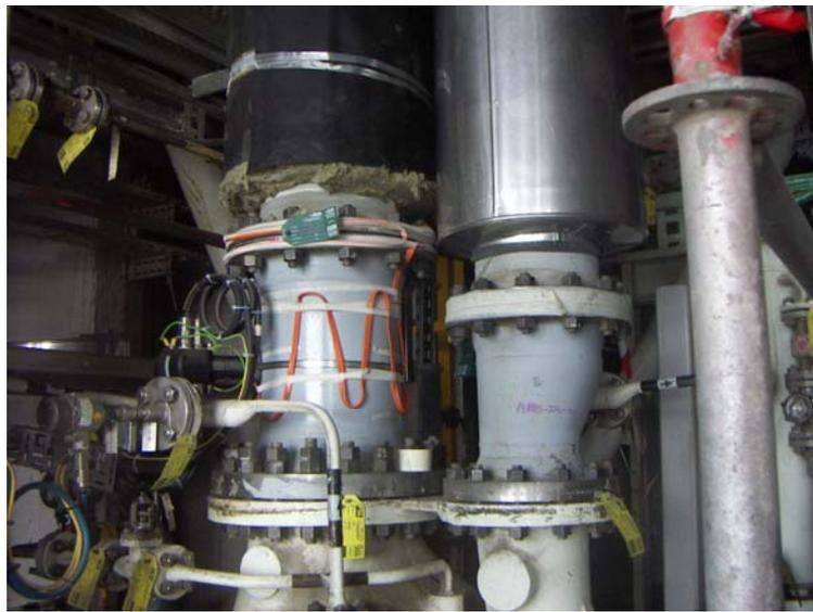
**Figura 31. Vista del traceado ( cable anaranjado que sirve para dar calor a las tuberías)**
