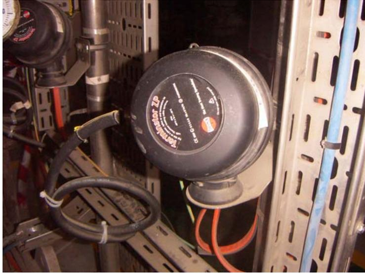
**Figura 32. Motor que alimenta al traceado de las tuberías para mantenerlas a la temperatura conveniente.**
