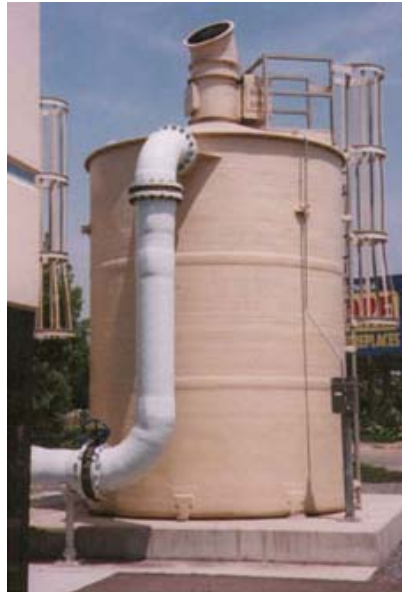
FIGURA 4.7: DESGASIFICADOR ATMOSFÉRICO.
