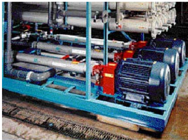
FIGURA 4.4: BOMBAS CENTRÍFUGAS MULTIETAPAS.
