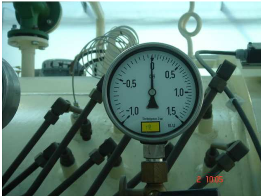
Imágenes 73 y 74 Chequeo de vacío y comprobación de válvulas
