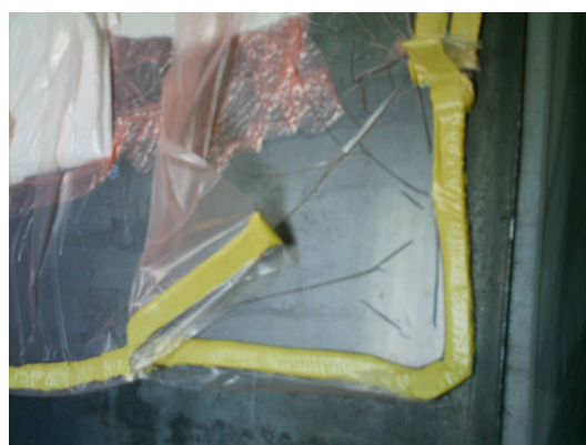
Imagen 29 Vista cercana de una pinza de pasta de sellado mientras se produce la compactación
