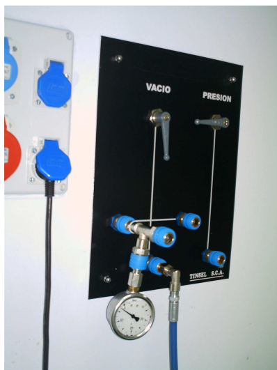
Imagen 28 Una de las tomas de vacío y presión de la sala limpia
