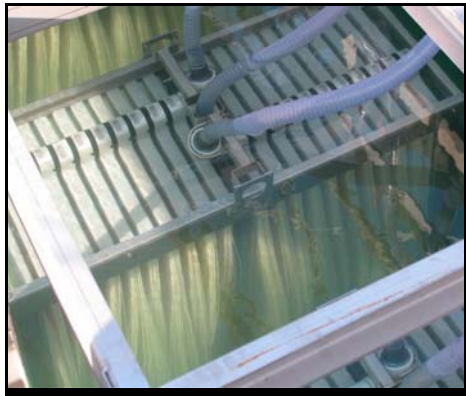
Fig. 7.2. Membranas sumergidas de fibras cruzadas en agua (“EDAR Guéthary, 9/12/03)
