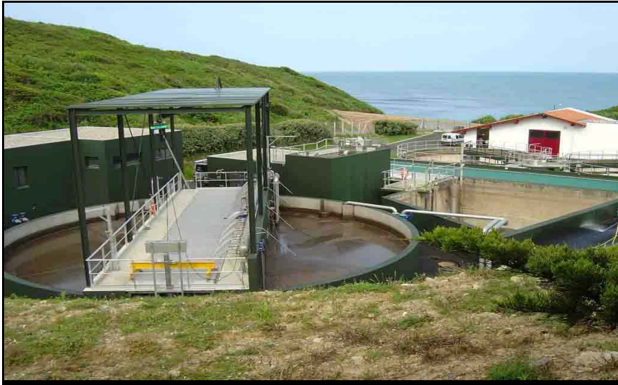
Fig.7.1 Vista de la EDAR de Guéthary ( foto del 25/06/04)
