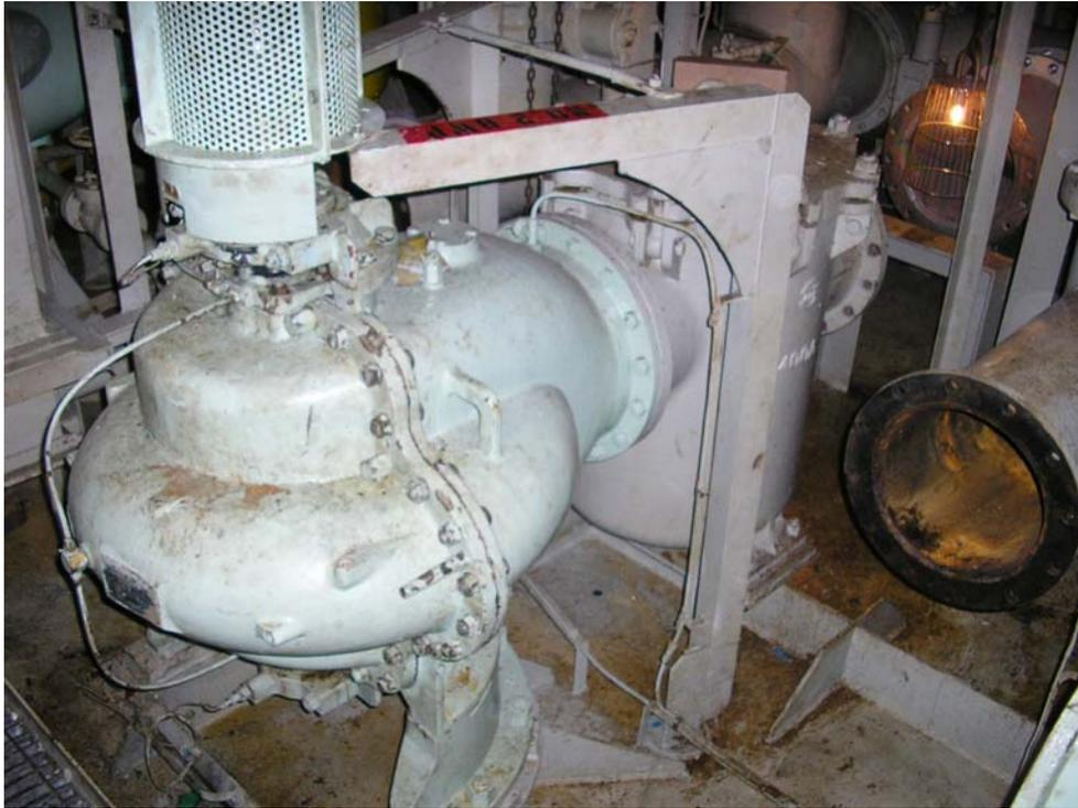
Figura 7.4.- Bomba centrífuga (con rejilla de protección del eje) y filtro
