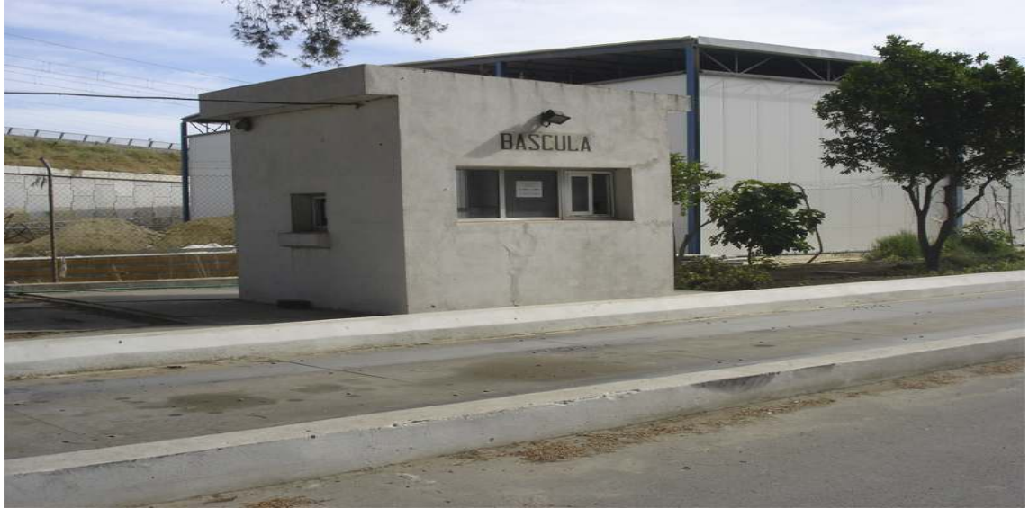
Báscula de pesada de camiones con caseta de control
