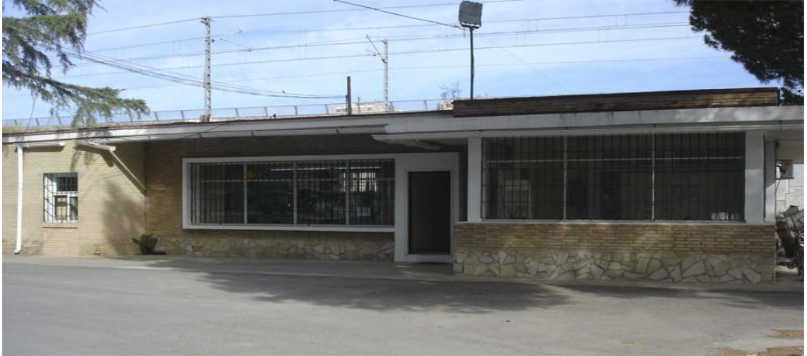
Edificio de oficinas de la Fábrica de Harina
