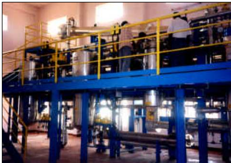
Figura 4.1. Planta multipropósito en India: 3 X 300 litros.
