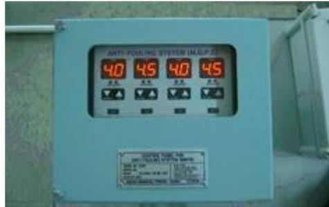
➤ **Ánodos.** Pueden ser montados en tomas de mar o en filtros, con las ventajas y desventajas que acarrea el lugar de instalación. El funcionamiento básicamente consiste en que el ánodo de cobre se va disolviendo mediante la aplicación de una corriente, emitiendo iones de cobre que reaccionan con el agua marina y acaba formando una capa anticorrosiva en el sistema de tuberías.
