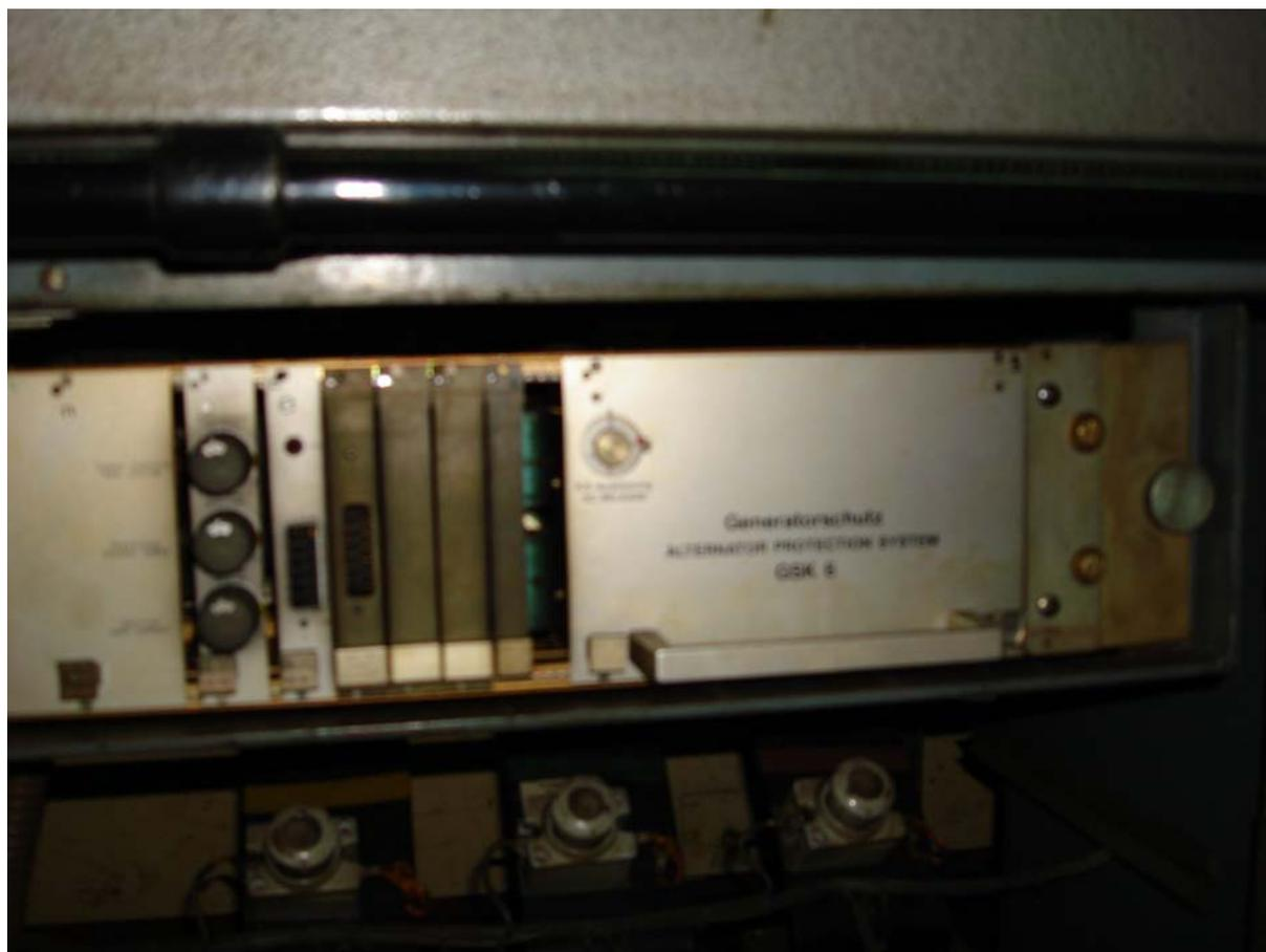
En esta imagen retratamos el sistema de protección del Alternador de los Generadores si bien en la Check List aparecen los valores medidos para los 3 Generadores instalados a bordo nosotros utilizamos este dispositivo como muestra representativa por ser común a todos los generadores y aparecer en el Cuadro Principal y en el de Emergencia en el que entra en acción el Generador nº 3.
