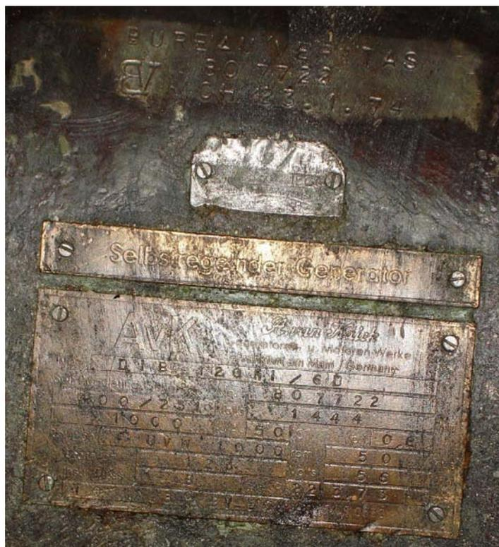
Debido al ambiente de trabajo en el que se encuentra, apreciamos el mal estado de la Placa del Generador 1. Vemos también la grabación de la inspección del Bureau Veritas en la fabricación del buque que data de 1974. Aunque en la fotografía no sea legible la información de la placa, estando allí y con cierta dificultad sí se puede obtener todos los datos que allí aparecen.
