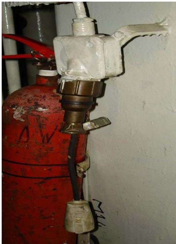
Como muestra de la inspección de los Circuitos de Alumbrado, mostramos nuestra conformidad al punto 8 de la Check List al comprobar el estado de este enchufe libre de daños mecánicos aunque no de suciedad por ser manipulado con las manos llenas de grasa por parte de los operarios de la Cámara de Máquinas.
