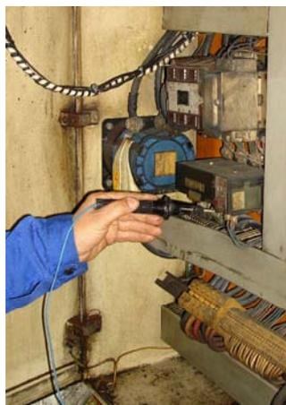
En esta ocasión reflejamos el cuadro eléctrico de una Bomba de Refrigeración de Agua Salada. Seguimos el mismo proceso del elemento anterior y realizamos las diversas mediciones.
