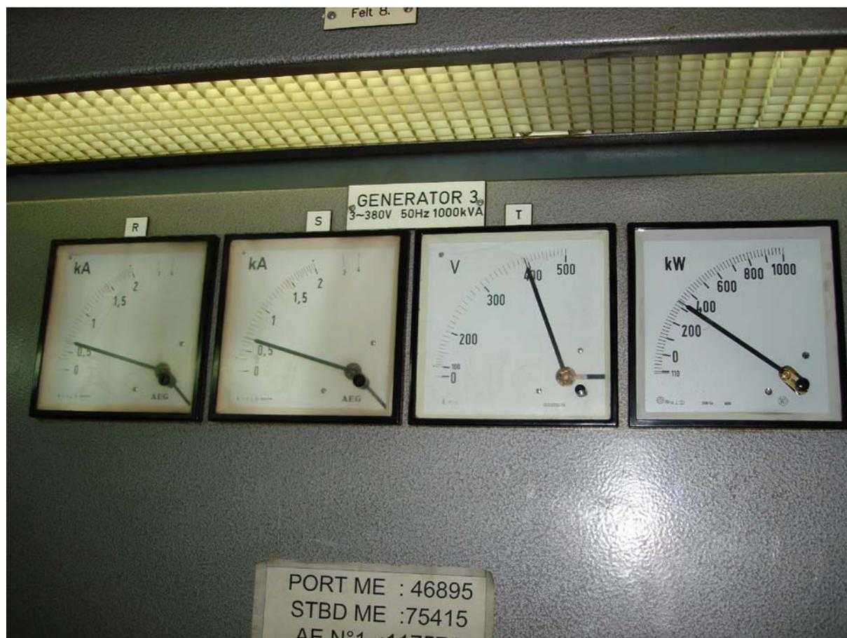
Tenemos aquí fotografiado el panel frontal del Cuadro del Generador 3. Con ello logramos ilustrar la Check List de los Aparatos de Medida al aparecer sus amperímetros, voltímetro y vatímetro. Cabe destacar como se miden 400 voltios y en la placa se puede leer como característica del Generador 380 voltios, siendo ésta la tensión a la alimenta a los equipos del Cuadro Principal.
