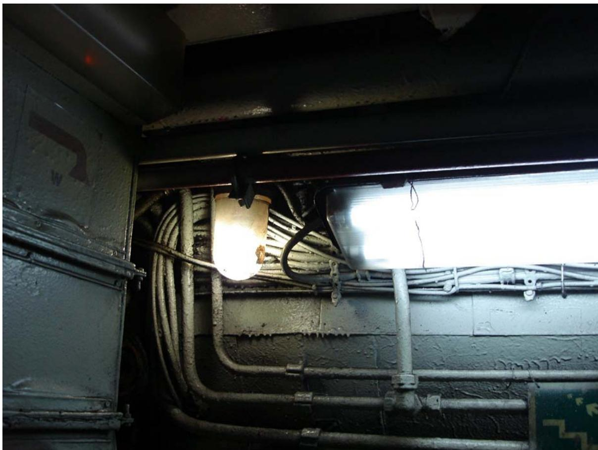
Como apoyo gráfico de la realización del informe de inspección de las instalaciones de emergencia adjuntamos esta fotografía. En ella podemos ver una luz de emergencia de la Cámara de Máquinas, requerido en el punto 2.4 de la Check List anterior.
