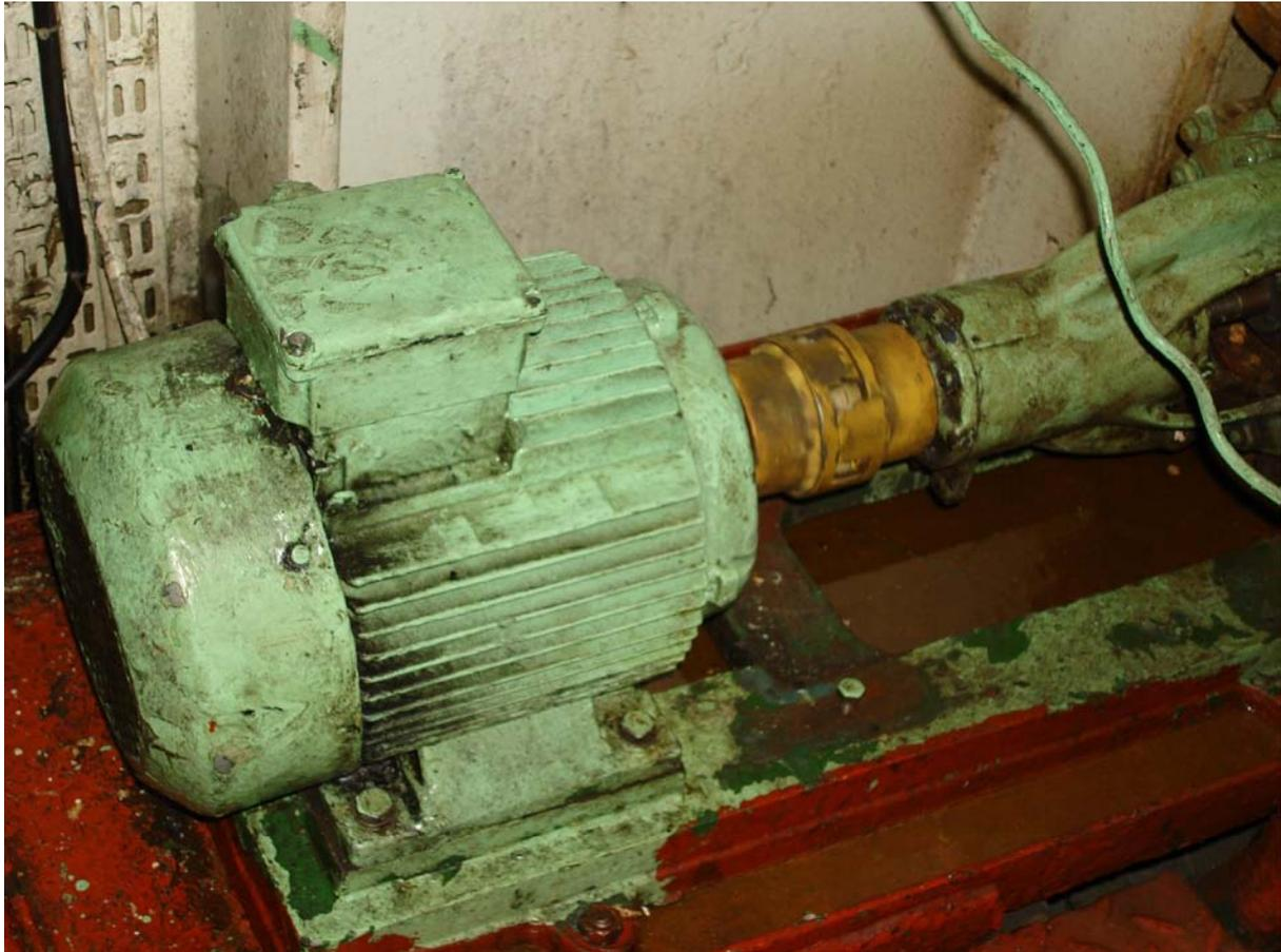
En pleno funcionamiento retratamos este motor eléctrico, el cual se hallaba en la Cámara de Máquinas. Vemos que está acoplado a un eje al que transmite el movimiento y su polín recoge aceite y lubricantes. Como efecto de su marcha y localización, la grasa recubre en buena parte su carcasa. Aunque chequeamos sin problemas la sujeción de sus pernos realizada correctamente evitando así vibraciones y desplazamientos del motor al trabajar, quedando satisfecho el punto 3 de la Check List previa.
