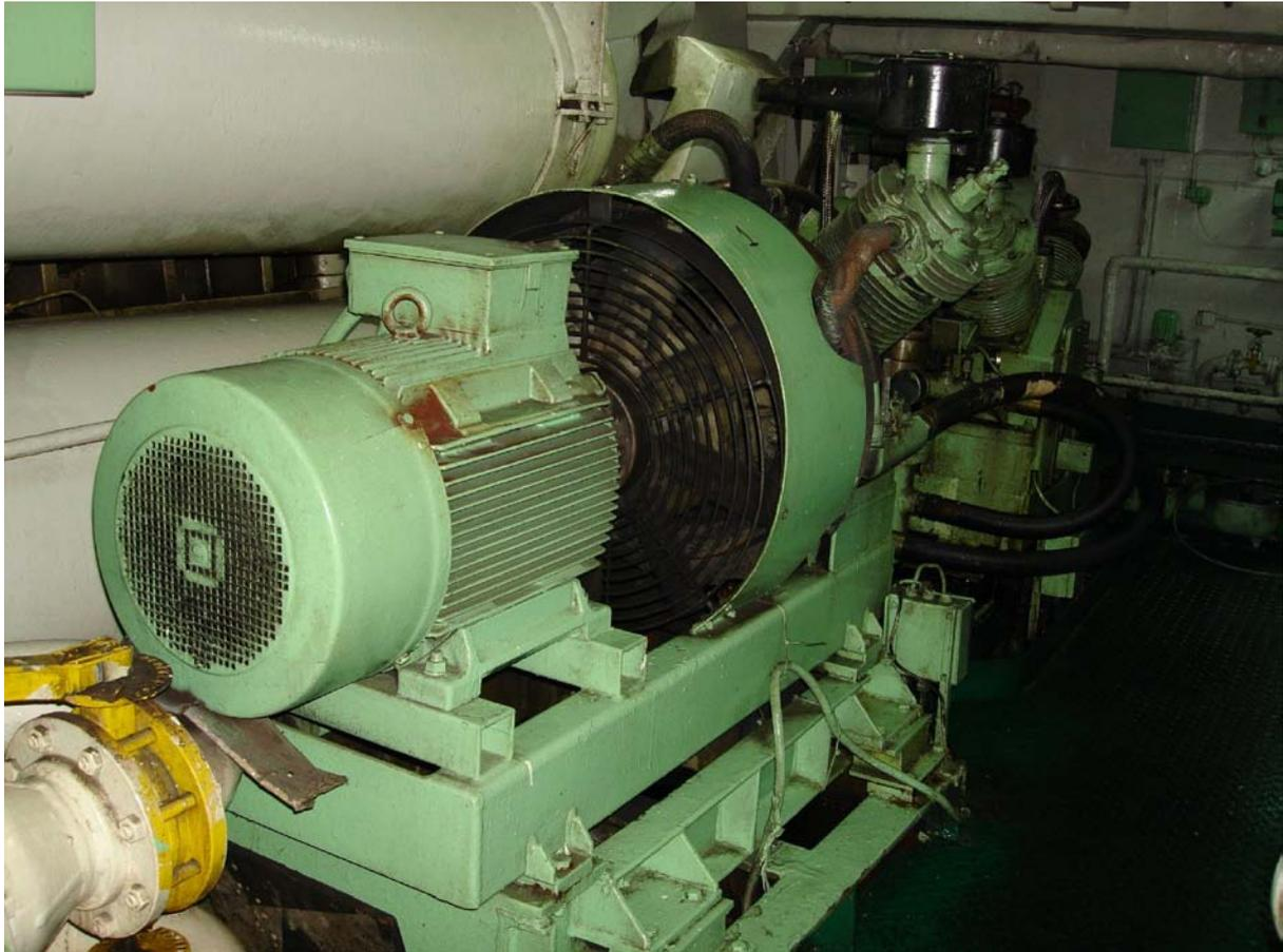
En esta Check List se nos pide hacer una inspección visual de un equipo comprobando la calidad y la correcta instalación de tal equipo en conformidad con los planos de diseño. Al tener acceso a pocos planos nos vimos obligados a escoger un aparato que apareciese en los mismos como es el caso del Compresor de Aire para el motor.
