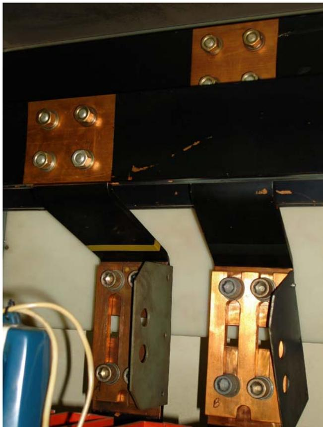
El punto 14 de la Check List anterior está aquí representado con total claridad, quedamos conformes ante la afirmación de que los terminales se unen a las Barras de Cobre mediante tornillos pasantes.
