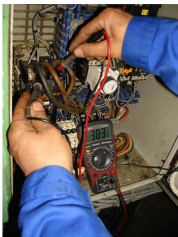
Como muestra de las mediciones hechas en el cuadro eléctrico de un Compresor de Aire, adjuntamos esta fotografía. Aparece un valor próximo a los 380 V a los que está alimentado el equipo. Posteriormente medimos los parámetros de los cables pedidos por la Check List.
