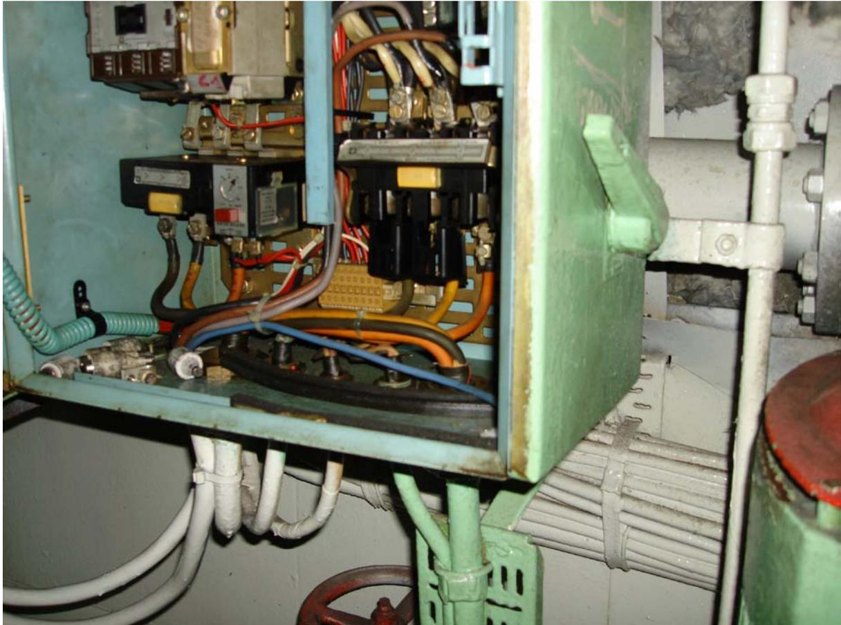
Por encima y a la izquierda la Bomba de Emergencia, se dispone su Cuadro Eléctrico, de hecho, la bomba aparece parcialmente en esta imagen. A éste le realizamos la inspección de instalación de cables ( Check List precedente ), y por la fotografía adjunta constatamos la correcta fijación de los cables tal y como se pide en el punto 3.
