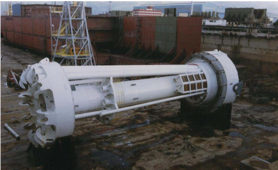
Mediante dos pórticos se inicia el izado del Turret en posición horizontal hasta librar la altura suficiente para iniciar el giro.
