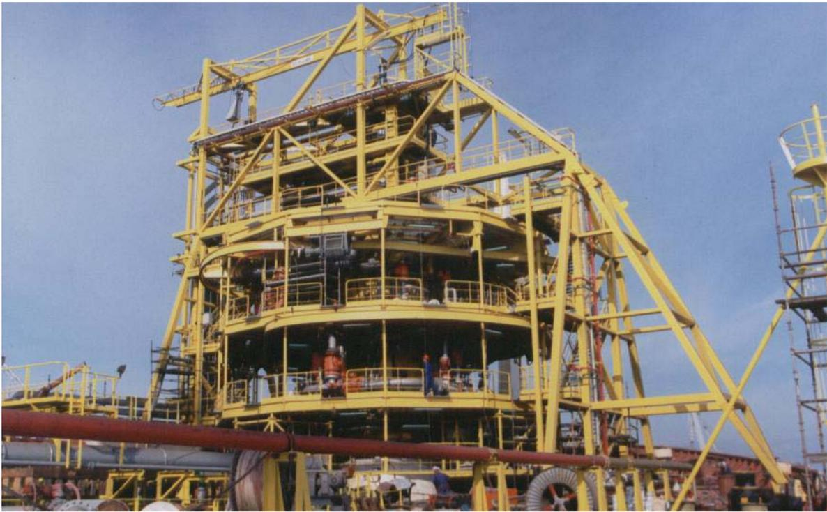
El sistema de fondeo y carga está diseñado de forma que el buque pueda aproarse a vientos de cualquier dirección.
