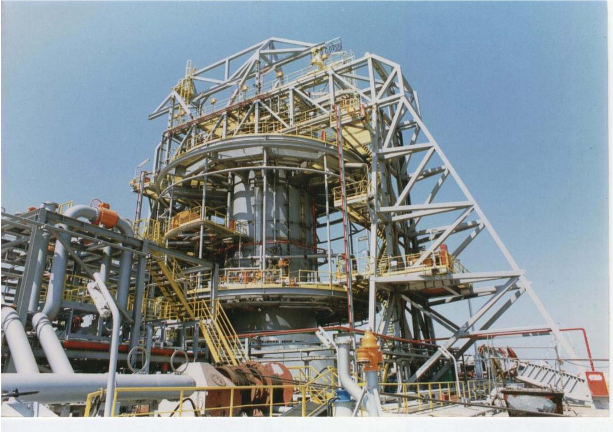
La estructura de la turntable forma parte del sistema de amarre del turret al lecho marino y se encuentra atornillada sobre la parte alta del Turret. La turntable consiste en una columna central con una brida montada en la parte baja y un soporte para el swivel en la parte alta.
