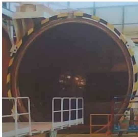
IMAGEN 332. Vista del volumen sin uso del Autoclave
