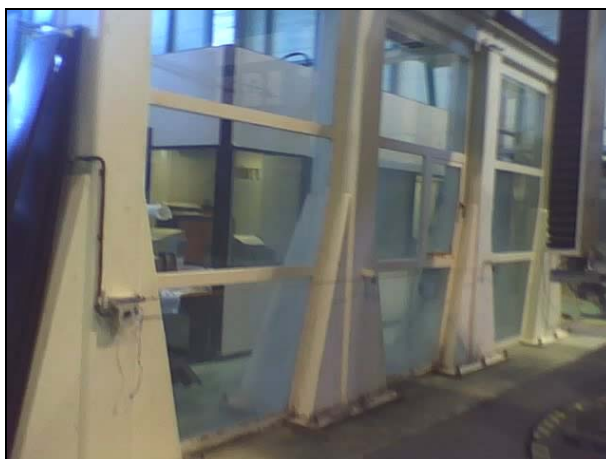
IMAGEN 251. Ventanas para la Inspección por Ultrasonidos
