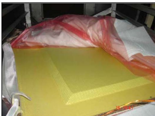
IMAGEN 199. Desmoldeo de una Pieza, eliminando material auxiliar
