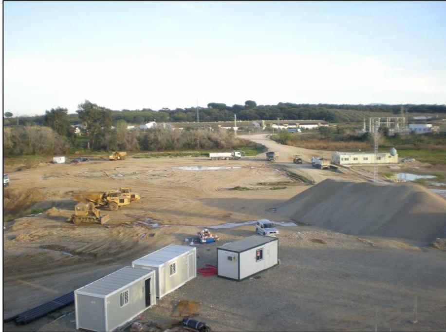
**Fig. 5.1.** Gravera Los Algarrobos, vista al este. Entrada, subestación eléctrica, zona de maniobra, oficinas y zona de almacenamiento de producto.
