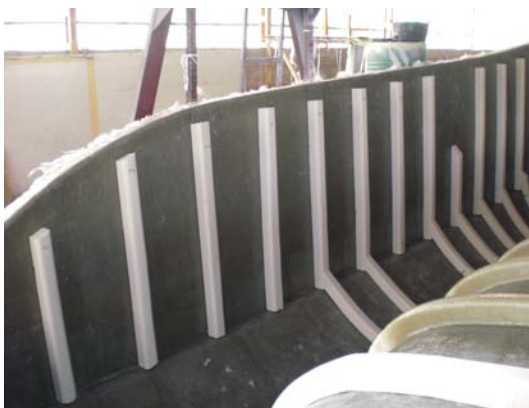
Refuerzos sin laminar
