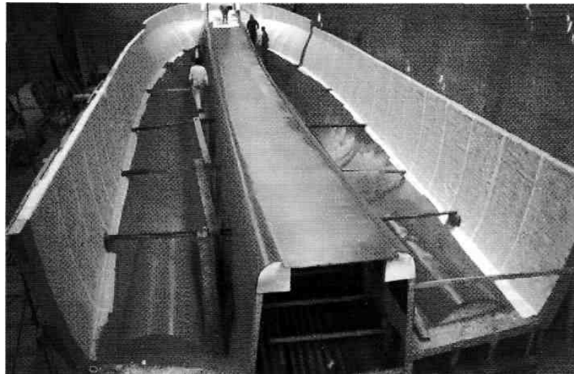
Colocación de la primera capa de laminado sobre el Gelcoat
