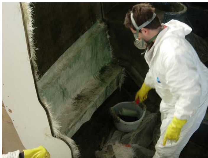
Aplicación de las capas de fibra de vidrio
