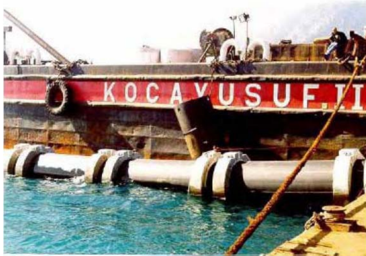
Fijación de contrapesos de hormigón a la tubería.
