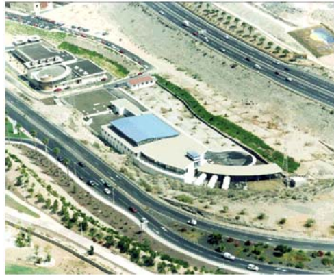
Desaladora de Adeje-Arona (Canarias).
