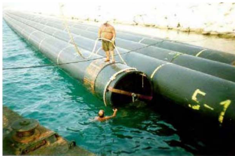
Almacenamiento de tramos de tubería.
