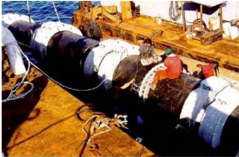
Embridado de dos tramos de tubería.
