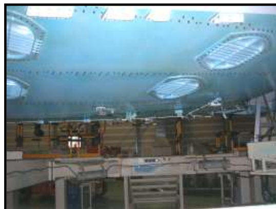
Visión de las cubiertas de los Man Hole
