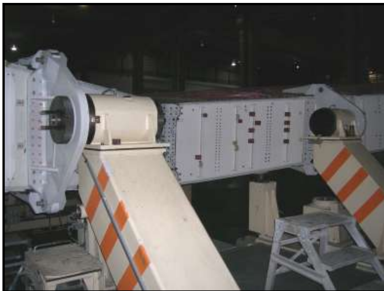
Visión de la zona central donde se encuentran los tricornos en la Fase III
