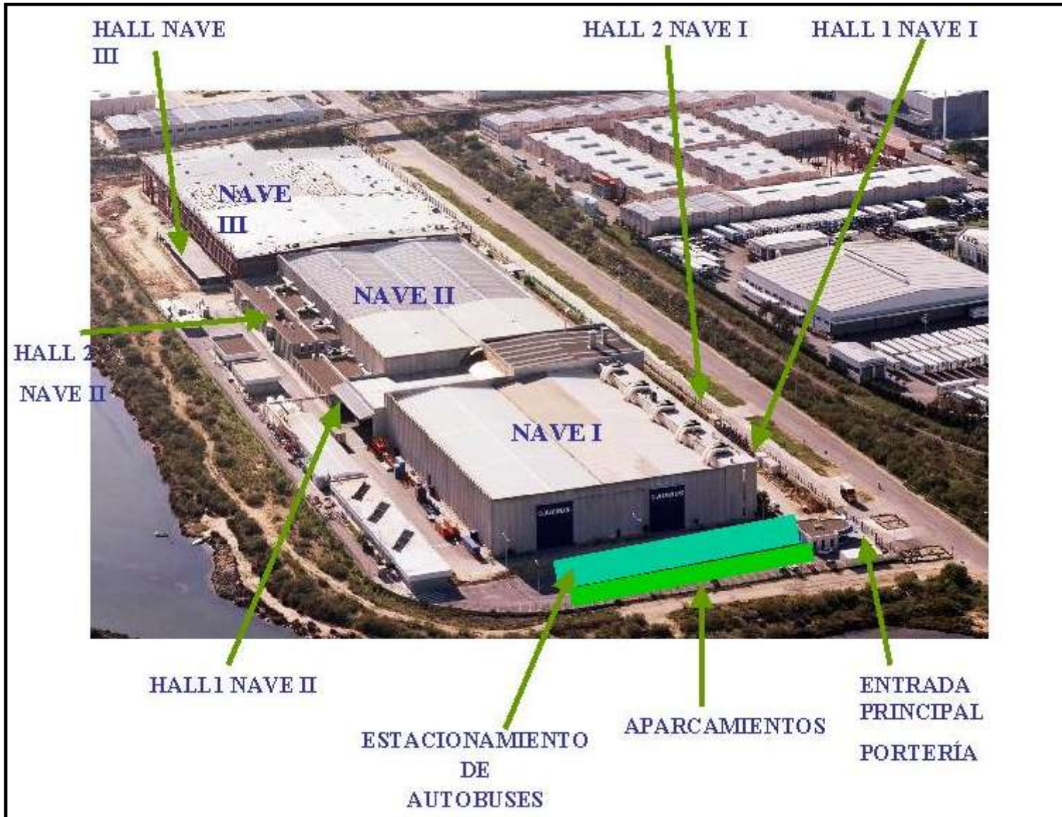
Figura 1. Vista de la Planta de Airbus Puerto Real
