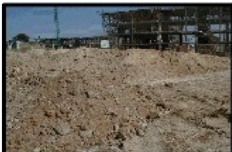
Figura 1-2. No se deben mezclar residuos de construcción y demolición con otro tipo de residuos, para facilitar su retirada a vertedero de inertes.
