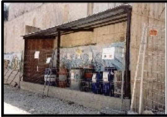
Figura 1-5. Ejemplos de almacenamiento de RP, en zonas acotadas, dentro de una instalación cerrada
