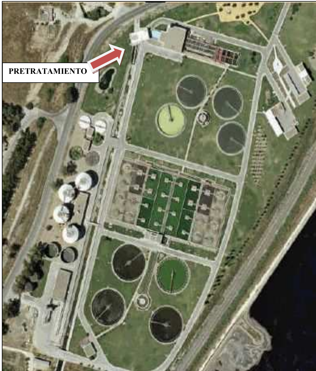
Figura 3: E.D.A.R. "Guadalete" de Jerez de la Frontera.
