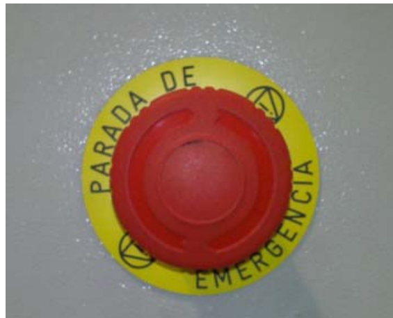
Figura 13. Interruptor de emergencia
