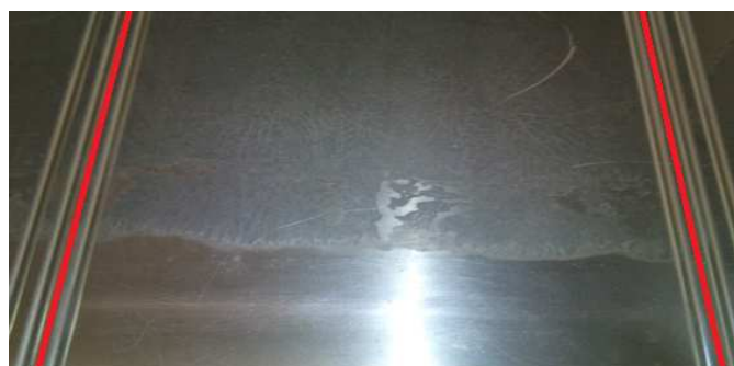
Fig. 154 Forma de colocar los lados de mayor longitud del perímetro de masilla (línea roja)
