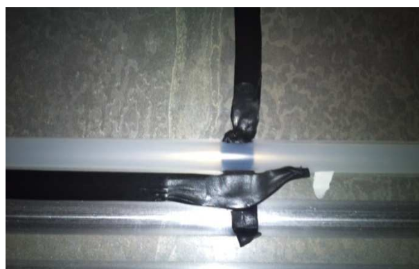
Fig.156 Fijación de un lateral del tubo en el lado del perímetro que se adapta al mecanizado.
