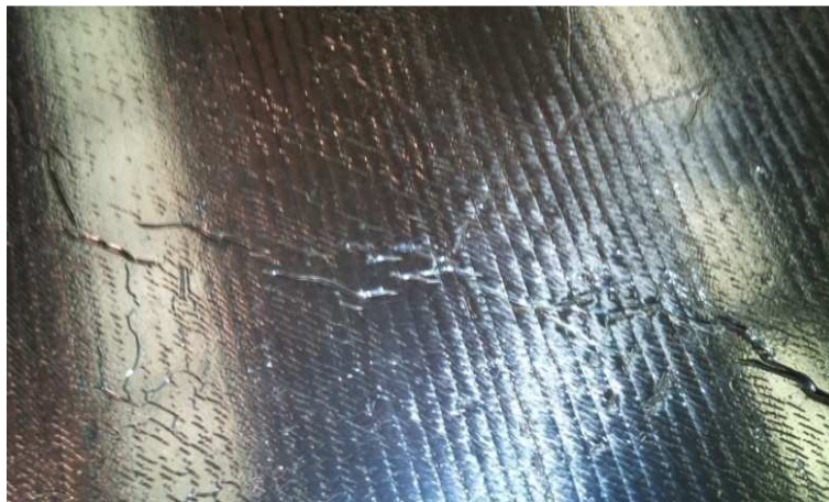
Fig.183 Defectos en la superficie en la estructura sándwich
