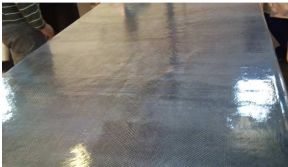
Fig.197 Colocación del film separador de alta temperatura.
