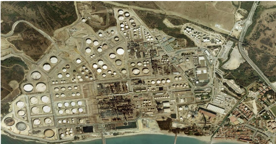
Fig. 4.1. Vista aérea de la Refinería Cepsa Gibraltar-San Roque
