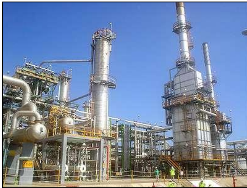
Fig. 7.4. Horno de procesos en Refinería
