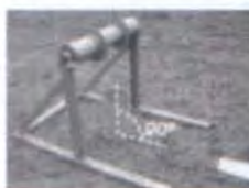
El rodillo deberá estar perpendicular a la dirección en el que está extendida la tubería.
